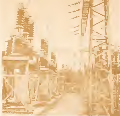
Subestação de Triagem — EFCB
