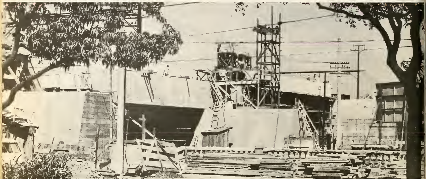
EFCB - Viaduto no Estado da Guanabara
