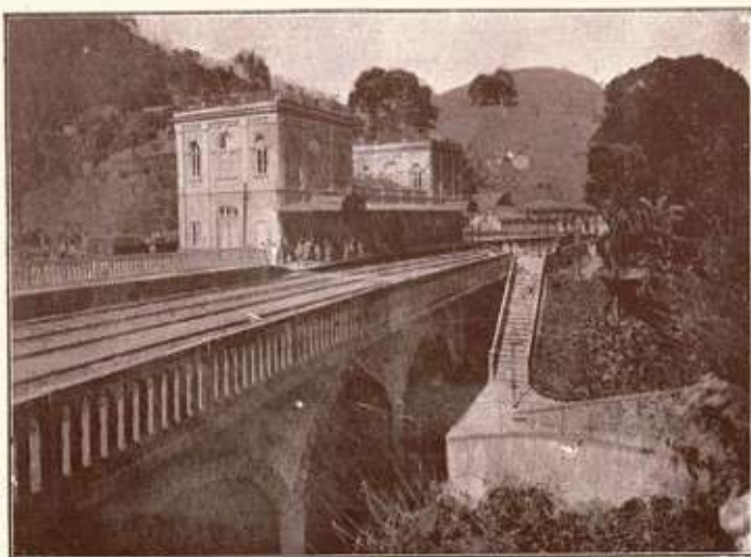
Estação de Rodeio
