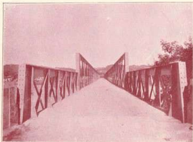
A ponte sobre o rio Parahyba
