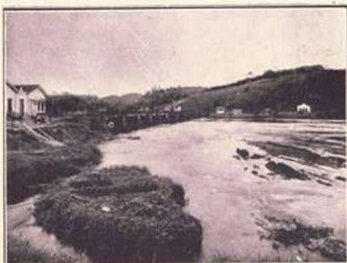
Ponte sobre o rio Muriaé
