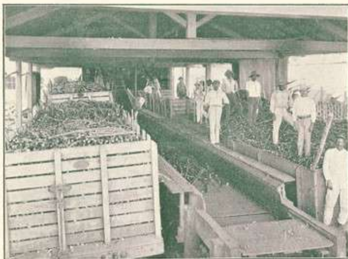
A descarga, dentro da usina, sobre a esteira de aço
