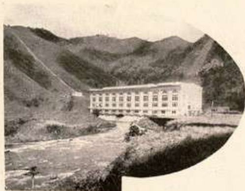
A Usina: descarga geral; plano inclinado para Ipé
