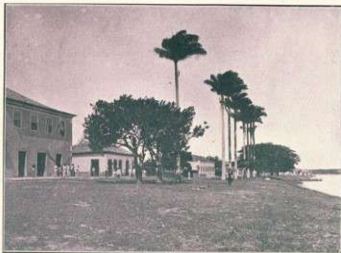
Barra de S. João: a Câmara Municipal e um aspecto da cidade
