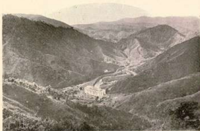
Vista geral da Usina. Acampamento e parte da estrada de ferro Fozes a Lage
