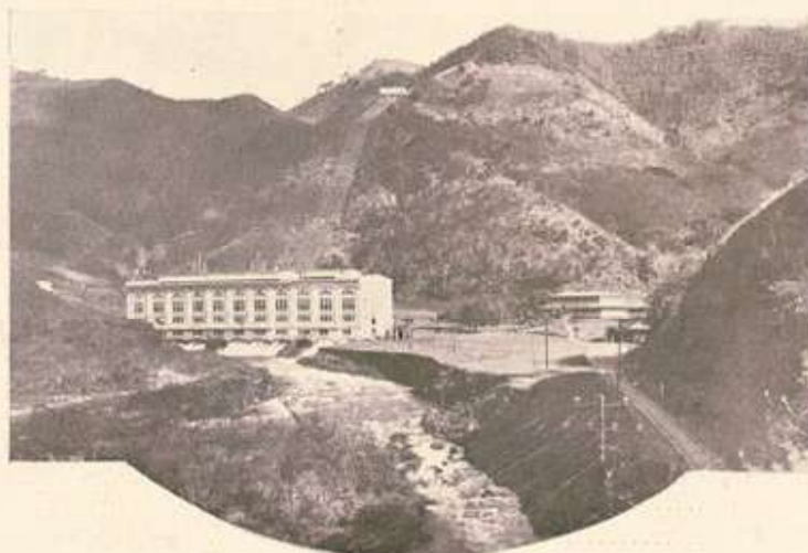
A Usina: acampamento; a casa das valvulas; encanamentos de alta pressão; descargas
