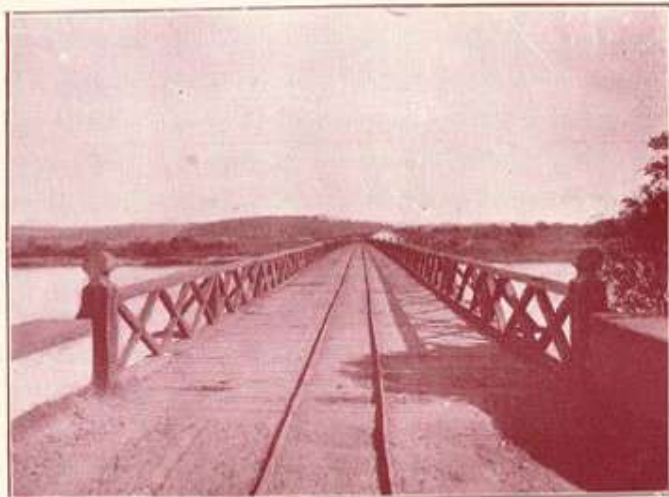
A ponte sobre o rio Parahyba
