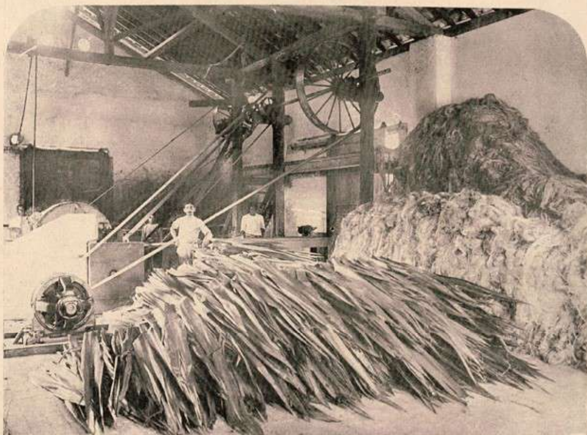
Folhas de pilão para a extracção da fibra; fibra extrahida e prompta para fição
