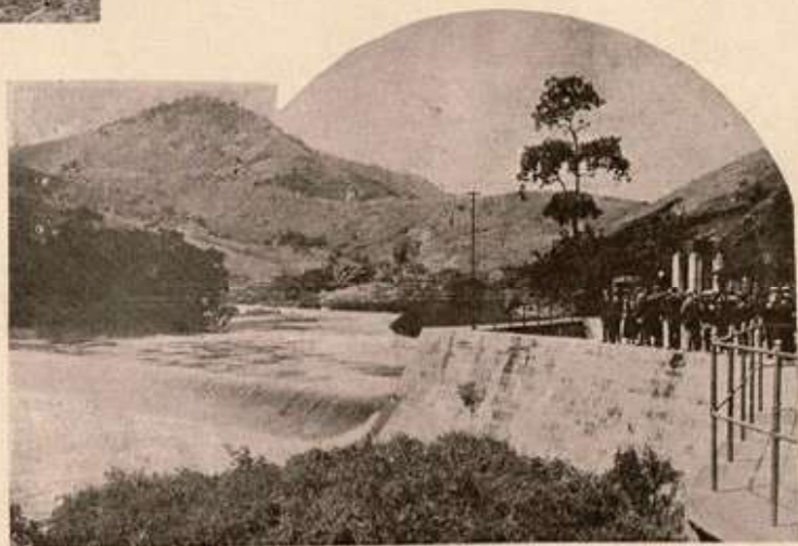
Barragem e reservatório de tomada de agua
