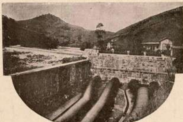
Vista da barragem e saída dos encanamentos
