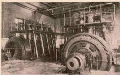
Geradores de emergencia
