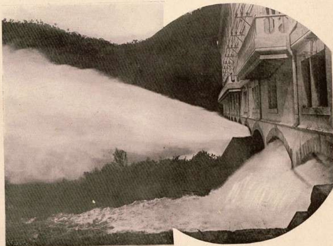
Descarga de uma das turbinas, de 9.000 H. P., pela válvula de segurança
