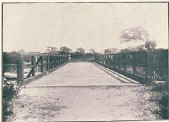
Ponte dos Leites
