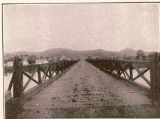
A ponte sobre o rio Parahyba
