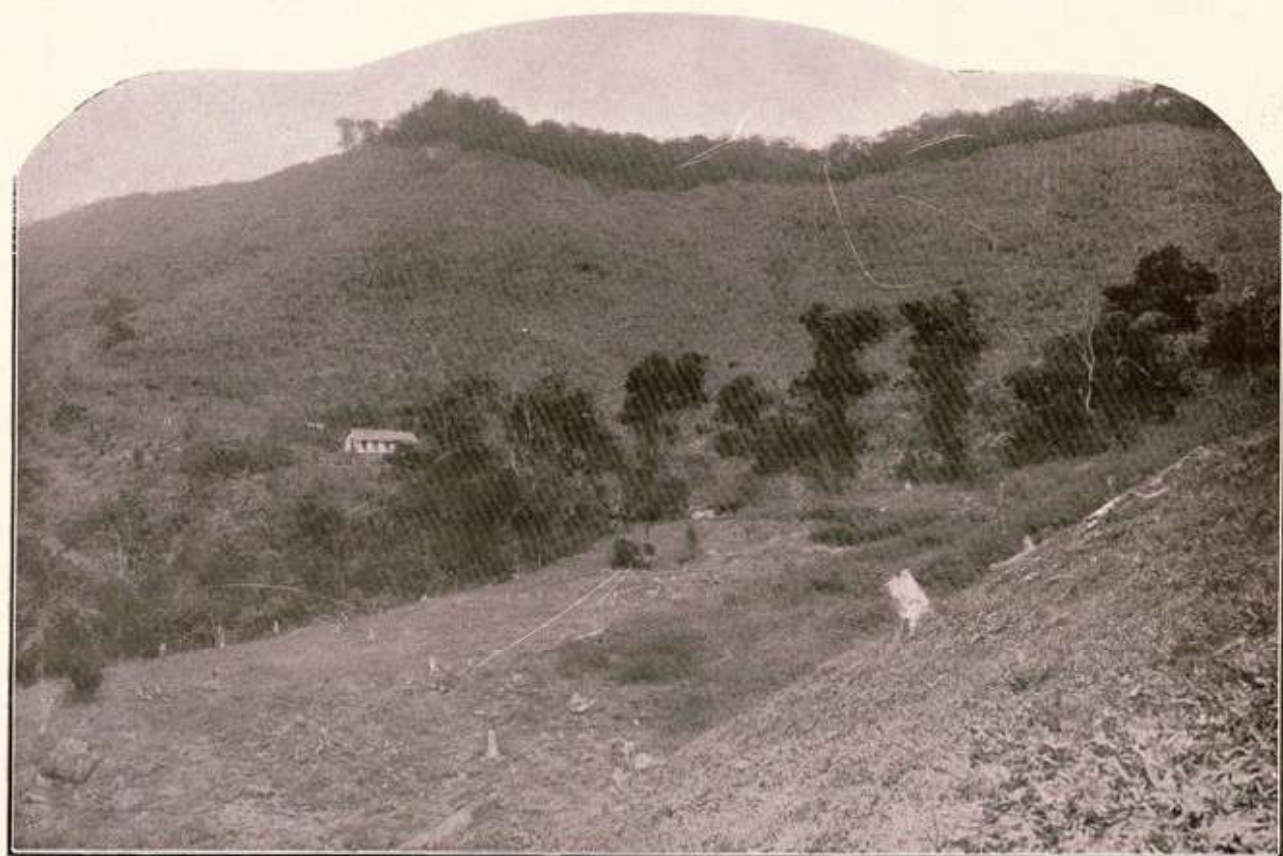
Um barão em Mangaratiba
