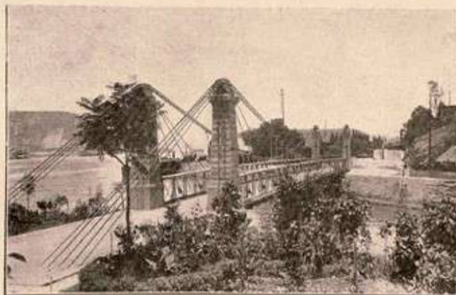
Ponte ligando as ilhas do Viamã e Santa Cruz
