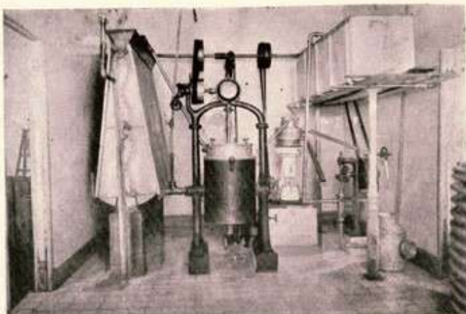
Na Fabrica de Manteiga—Campo Belo—Esterilizador
