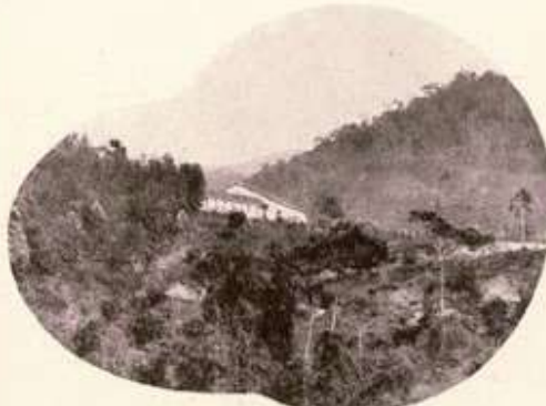
Fabrica de tecidos de seda, no Bingen - Petropolis. (antigo edificio)
