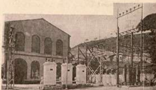
Sub-estação transformadora de Sete Pontes — S. Gonçalo
