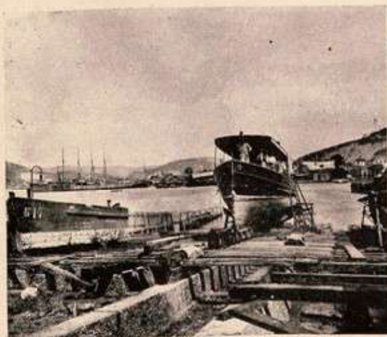
Carreira para reparo de embarcações pequenas
