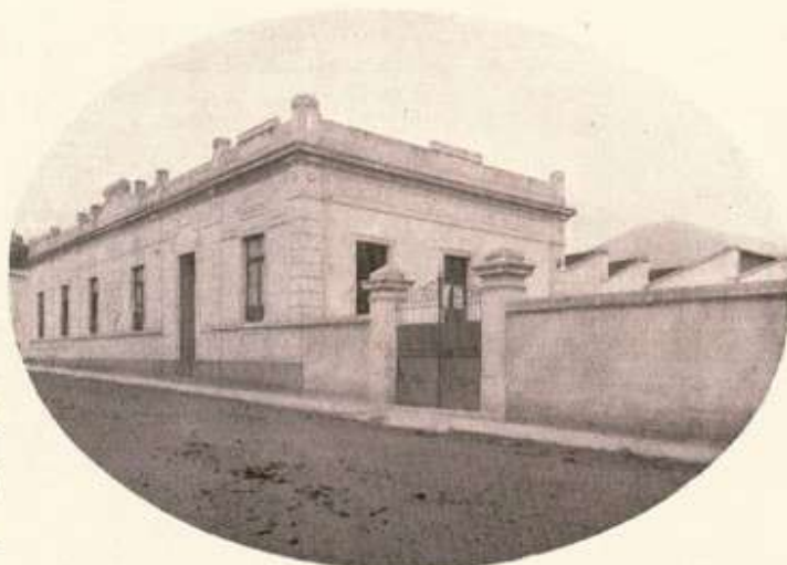
Edificio da fabrica
