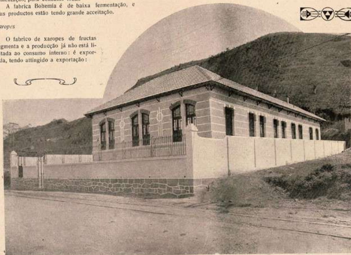
Edificio da Fabrica
