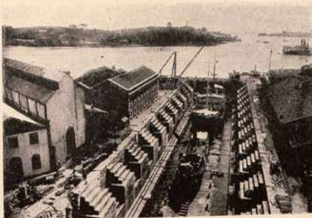
O dique, em secco
